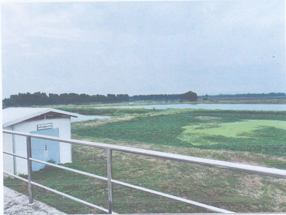
ภาพก่อนปรับปรุง
