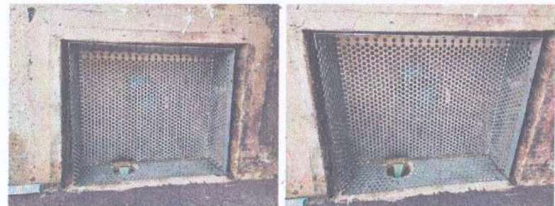
- ใส่ตะแกรงปลายท่อระบายน้ำ
