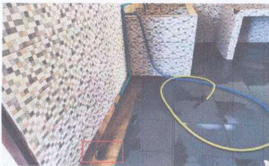
- ปลายท่อระบายน้ำภายนอกไม่สามารถป้องกันสัตว์พาหะเข้าไปในอาคารโรงฆ่าสัตว์ได้
