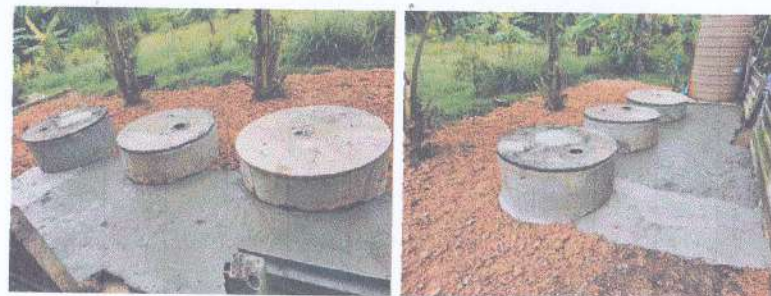
- ปรับปรุงซ่อมแซมระบบบำบัดน้ำเสีย
